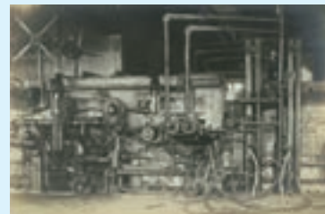
コルバーン式板ガラス製造設備
